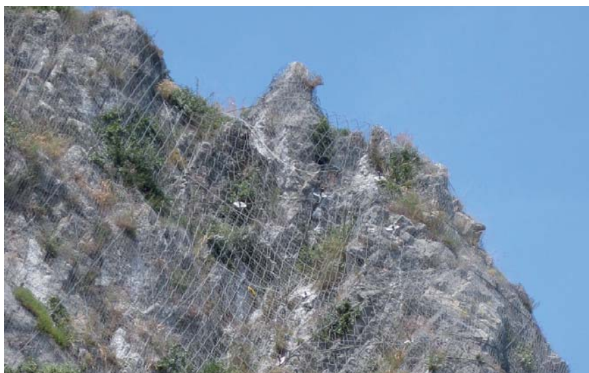
Rivestimento ad alta resistenza SPIDER® su aree fortemente fratturate
