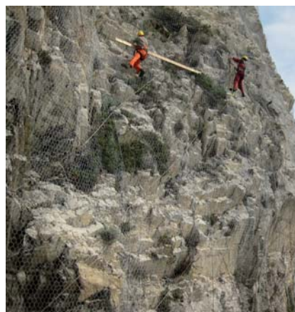
Fasi di tracciamento della barriera RXI - 200
